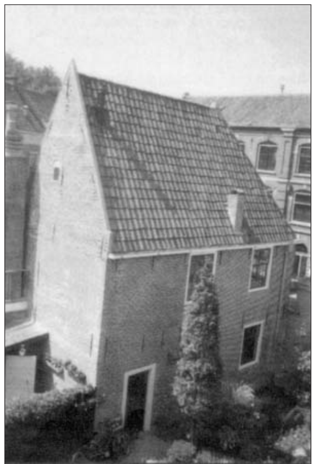
Het Timmermansgildehuis te Hoorn mei 1992 na de restauratie.
